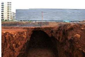
写真 65 SX373 北室部天井（南から）
