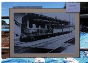
写真 11 国鉄時代写真パネル
