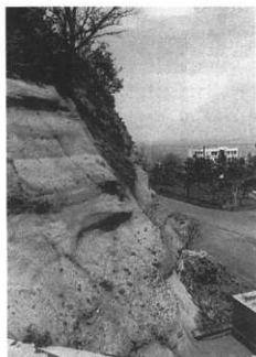
写真5. 円山外壁の形状 (施設屋上より)
