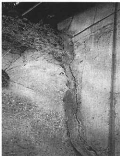
写真2. 保存施設南側の壁と円山の接合部
