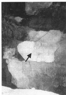
写真6. 洞窟最奥部の浮いた岩体 (矢印部分、昭和59年)
