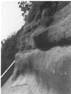
写真1. 保存施設屋根と円山の接合部
