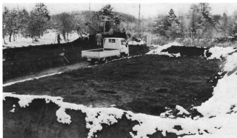
2、第2回工事立会
