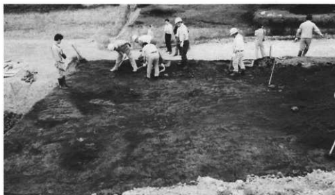
1、第1回工事立会
