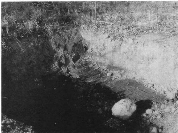
掘削状況(約1.0mの状況)
