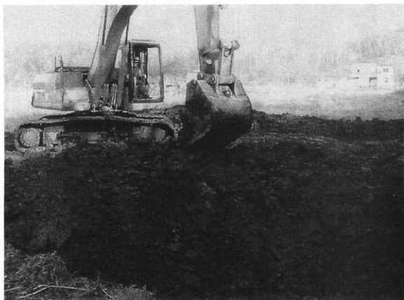
埋め戻し状況
