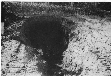
掘削状況の確認
