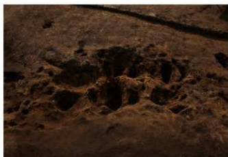
2 1号溝流水痕跡(東から)
