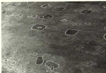
T-0 SB-02 SB-03間 SA-05 および SA-03 (南より)
