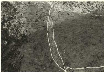
道路B溝①②間
