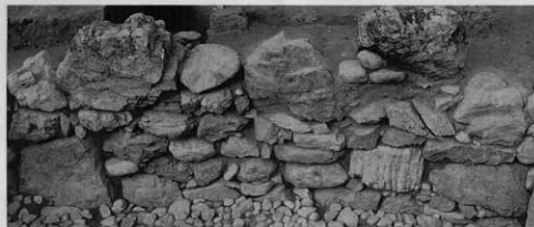
左側壁(右が奥壁)
