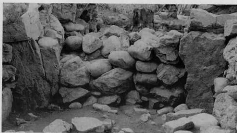
閉塞状況 (玄室から)
