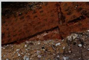
主軸断ち割り状況4-5m付近(南より)
