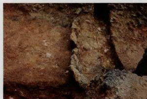
間仕切り障壁右側(北より)
