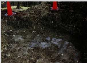
掘削状況断面（南より）
