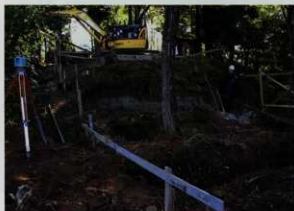
展望デッキ設置部分（南より）
