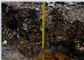
基礎工事部分断面 (西より)
