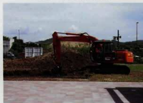
重機作業風景
