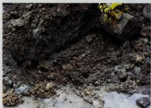
基礎掘削部分（東より）
