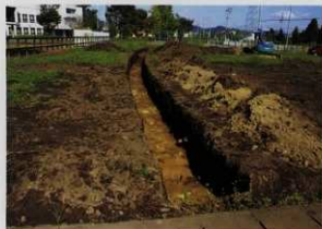
東西トレンチ西部分 (西より)
