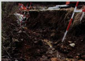
護岸工事部分全景（南より）
