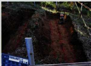
基礎掘削部分平面（南より）
