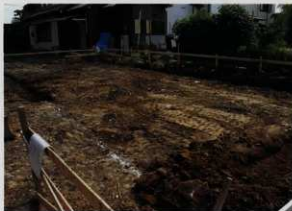
住宅部分基礎工事風景（北より）
