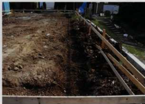
住宅部分基礎工事西側部分（北より）
