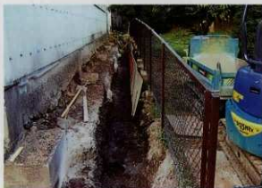
掘削溝全景（西より）
