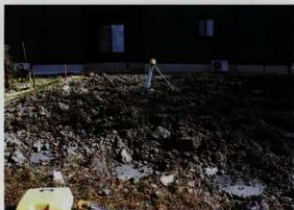
掘削後（西より）
