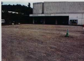
既設舗装除去後 (北より)
