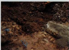
基礎掘削部分（東より）
