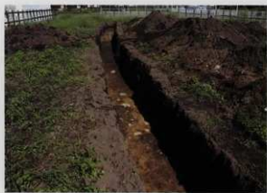
東西トレンチ東部分 (西より)
