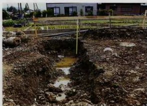
基礎工事部分 (西より)
