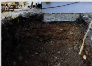
住宅側掘削ヶ所断面（西より）
