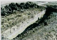
山岸・伊川地内第1トレンチ
