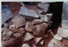
羨道西側壁崩壊部
