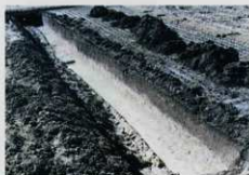
山岸・伊川地内第4トレンチ
