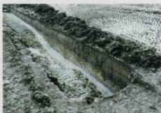
山岸・伊川地内第3トレンチ
