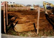
中山道重機による掘り下げ
