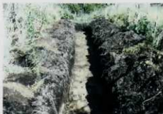
富士ノ井地内第3トレンチ
