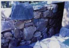
積み直し後の西側壁
