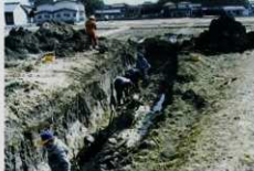
山岸・伊川地内作業風景
