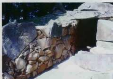
修景後の羨道部西側壁
