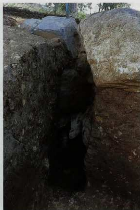
西側壁裏込状況
