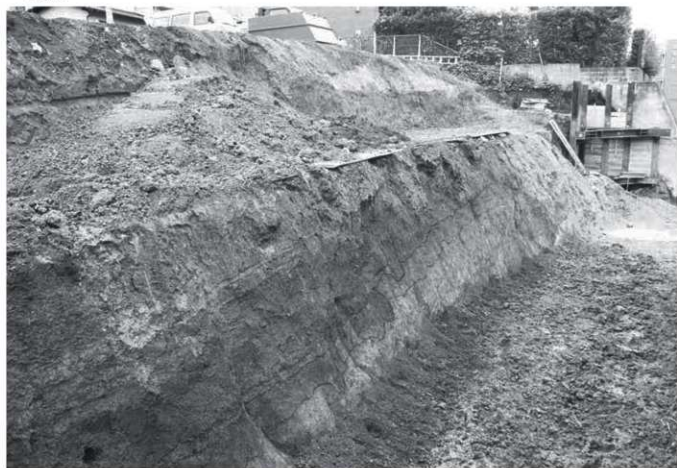
第 299 次調査区上・下段 土層状況（南西から）
