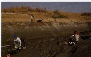
2 第48号沟迹光波测量状况
