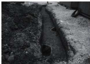
SP136・139 完掘(北西から)
