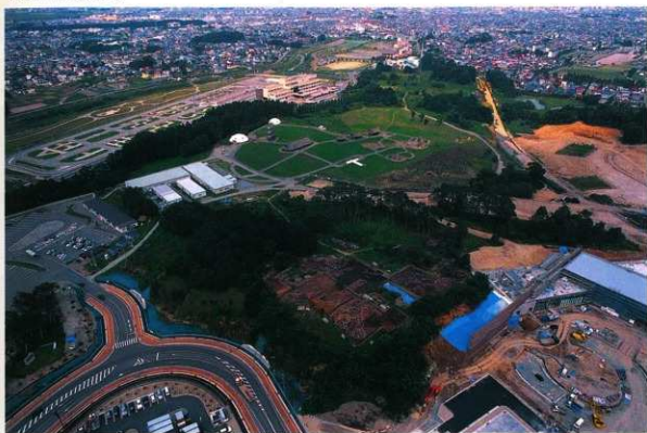
第24次調査区遠景（南から）
