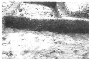
道路面上堆積状況
