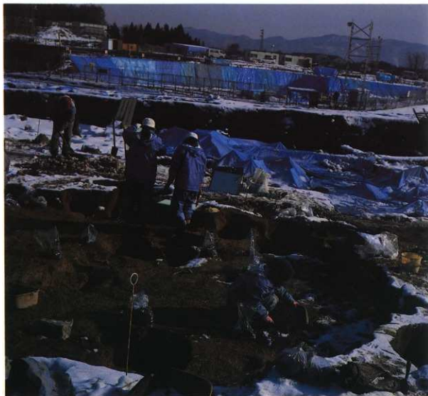
作業風景(平成5年12月)
