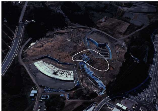
旧野球場建設予定地（北東から 白線内が北盛土）
