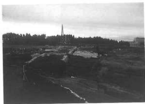
南盛土近景 (南から)
