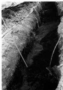
4 南側の第III層損傷部分 (No.10付近)
