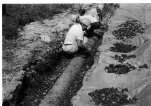
2 排水溝掘り出し作業
