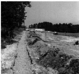
写真1 暗渠排水施設(南東から)
