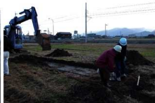
写真1-2 重機による表土剥ぎ取り状況
