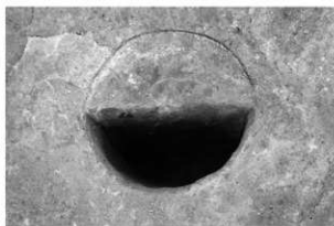
写真 52 SB7P2 断面 (南から)
