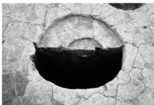
写真 147 SB9P7 断面 (北東から)
