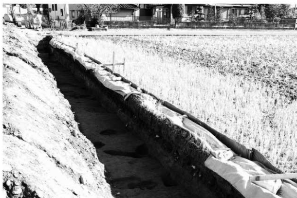
SD37 付近（北西から）
