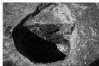
10069 ビット 柱痕確認
