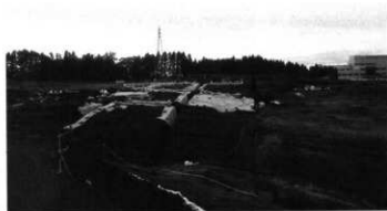
南盛土近景（南から）
