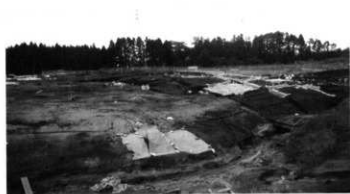
南盛土近景（南東から）
