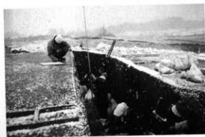
1 トレンチ作業風景
