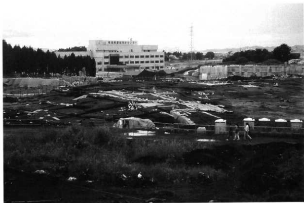
南盛土近景（南から）
