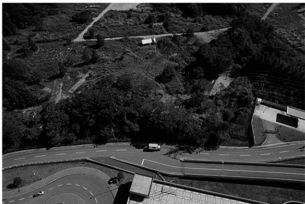
第28次調査区全景（写真左下が北）
