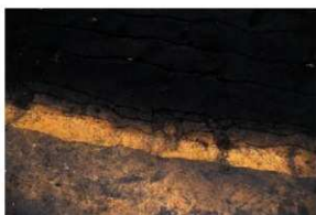
貼り土の断面（東から）
