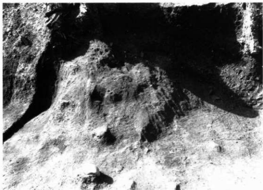
C调查区 E 7地点崩塌(?)
