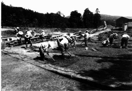
作業風景(北から)
