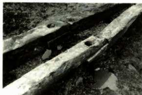
Fig. 215 百間堀石垣の駒木の接続
