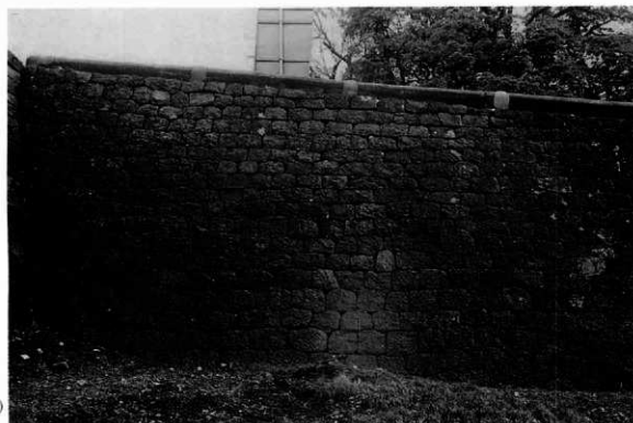
百間堀石垣(部分)
