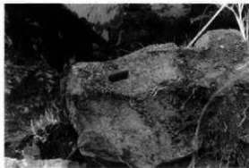
Fig.207 石材上に掘られたホゾ穴
