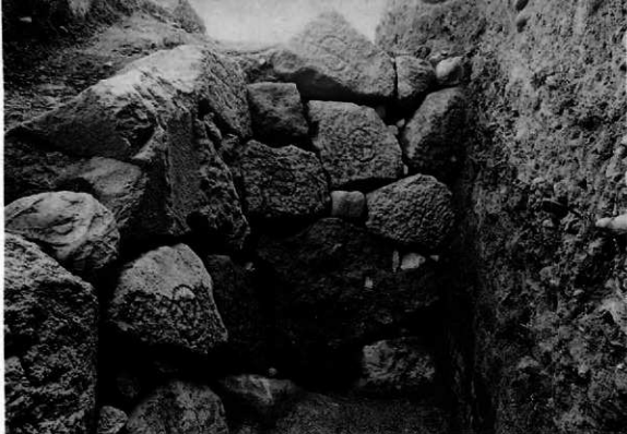
白鳥堀石垣(部分)
