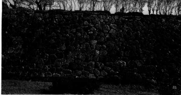
百間堀石垣(部分)
