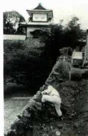
Fig.28 石垣解体作業
