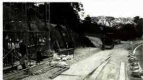
Fig.13 調査未了区の工事進捗
