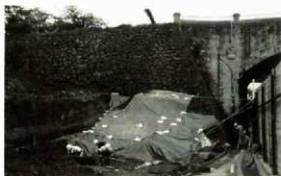
Fig. 27 盛土にシートで保護する
