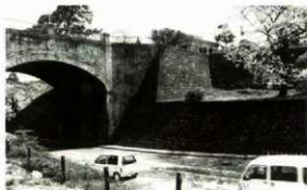
Fig. 5 掘削前の兼六園調査区
