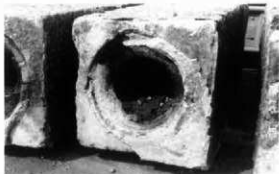
Fig.47 辰巳用水石管内部(白く見えるのがシジミ貝)
