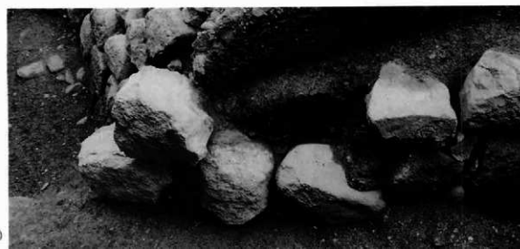
白鳥堀石垣(部分)
