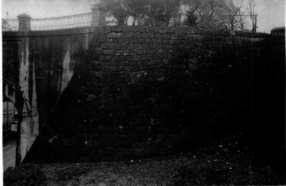
百間堀石垣(部分)
