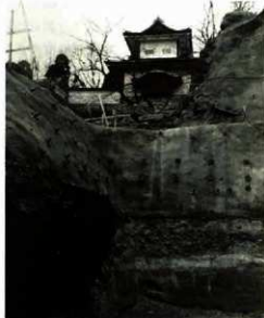
Fig. 7 谷底より石川門を見る
