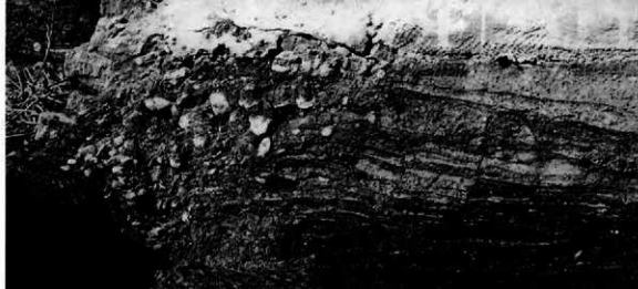
百間堀石垣裏込め (部分)
