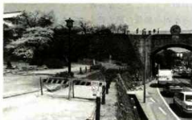
Fig. 4 掘削前の沈床園調査区
