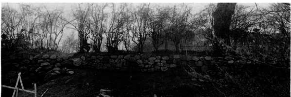
白鳥堀石垣(部分)
