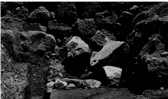
百間堀石垣 根固め状況
