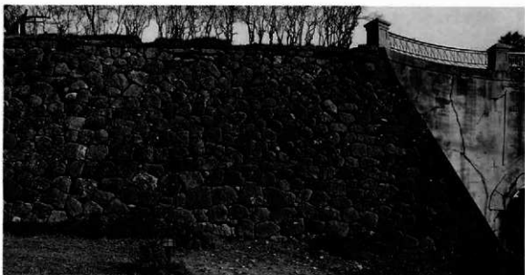
百間堀石垣(部分)
