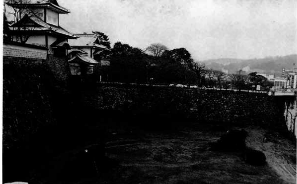
百間堀石垣 (沈床側側)
