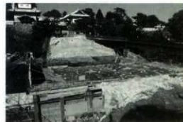
Fig. 11 石川橋解体と石川門
