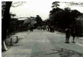
Fig. 2 掘削前の旧石川橋
