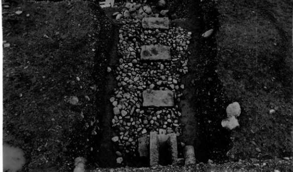
石管取り上げ 敷石状況
