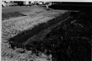
27-11 金屋遺跡1T完掘 (北より)
