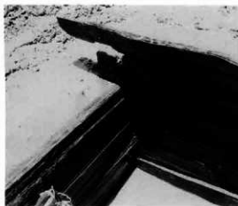
SE702 井戸側北西隅
