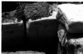
Fig 17 1号墳第二段石材設置状況
