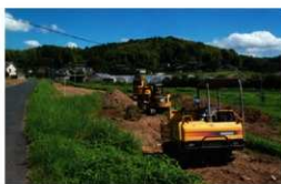
重機による表土除去
