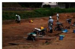
国土座標設置
