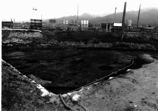
2. 14~15Y区完掘状況 (西より)
