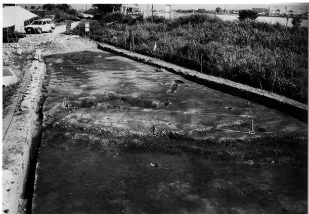
11 2号掘立柱建物跡全景（南から）
