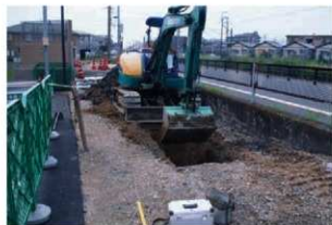
第48次調査4トレンチ状況（北東から）
