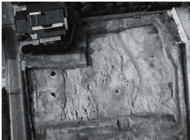
第180次調査北側全景（上が北）
