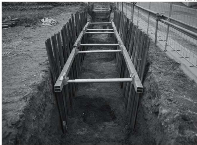
第 268 次調査 A 区完掘状況 (南から)
