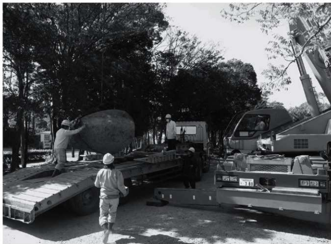
推定朱雀門礎石移設作業風景
