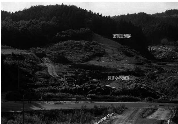
2 調査前近景（平成16年7月）（東から）
