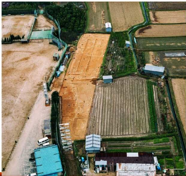
調査地遠景（北西から）
