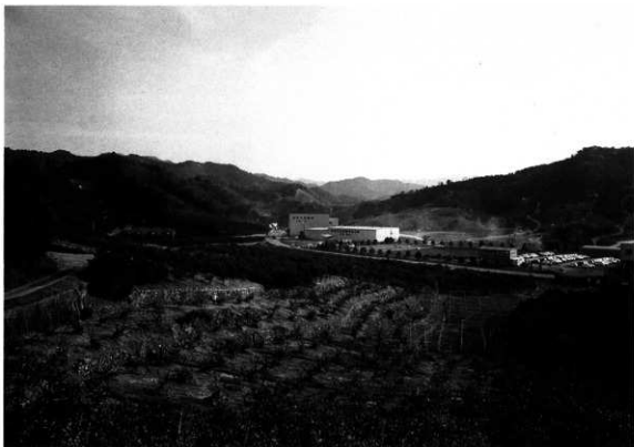
HHT 地区全景(北から)
