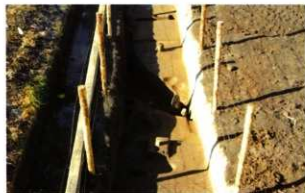
2 第7・8・9号住居跡・第2号溝跡(東から)
