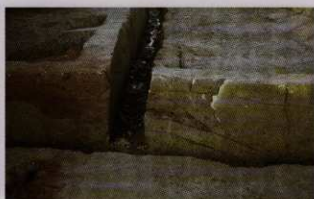
7 第1号堤防状遺構東西断面 (2)
