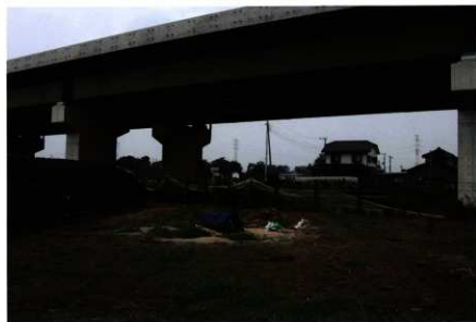
3 A区現況 (平成21年9月)
