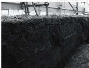
4. 1区1面土間検出状況 (北東から)
