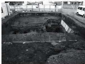
7. II A区1面SD01全景 (南から)
