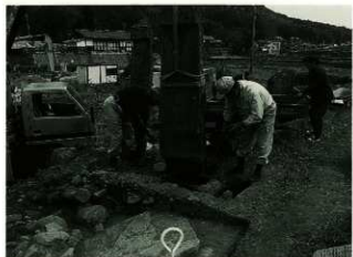
11. 板碑移設作業風景（南西から）
