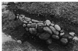
平堰跡東側（立面図⑩）の石積み（南東方向）
