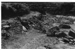
馬留橋付近の風化部分（南西方向）
