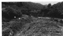
⑥馬留橋付近の風化部分 (南西方向)
