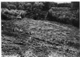
B区からA区を望む
