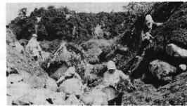
⑨平堰跡中央部巨石付近の作業状況
