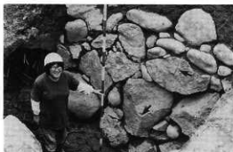
平堰跡中央（立面図③）の石積み（南東方向） ※他の地点とは異なり、鋭角的な石が多く、クサビ跡も見られる
