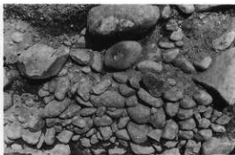
平堰跡中央（立面図②-2）の石積み（北方向）
