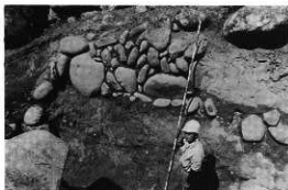
平堰跡西側（立面図①）の石積み（北西方向）
