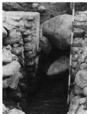
「七右工門穴」付近の余水吐・水門（南方向）
