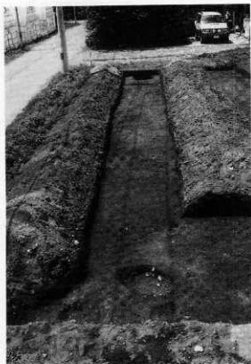
トレンチ完掘
