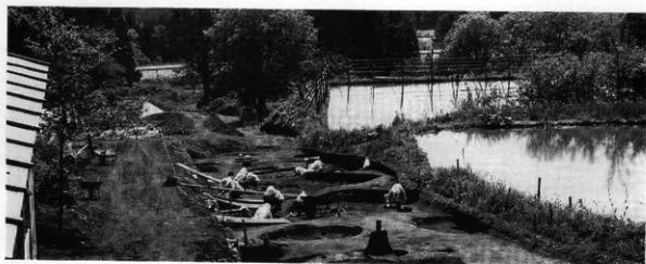
作業風景（西から）
