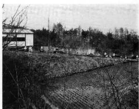
作業風景（南から）
